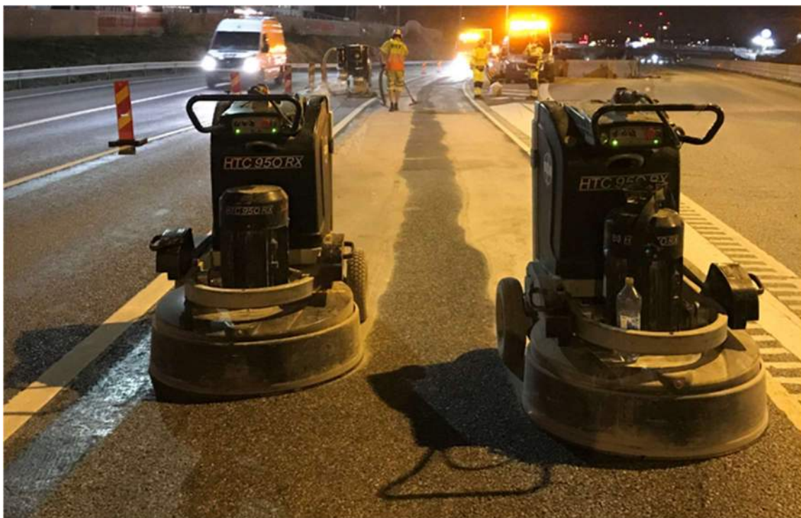
Figur 29. Exempel på slipning samt erhållet slipdamm bakom maskinerna. Foto: Skanska.
