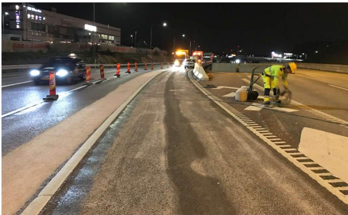
Figur 31. En slipad och rengjord yta i körfältet i bildens mitt samt ett hjulspår med kvarliggande slipdamm till vänster i bild. Foto: Skanska.
