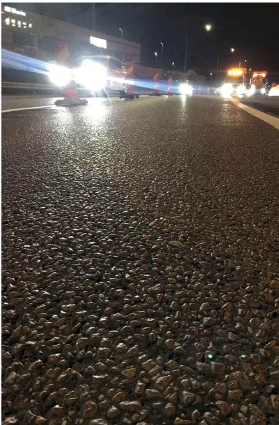
Figur 26. Exempel på ABS 16 beläggning på E4/E20 före slipning. Stenarnas ytor är blankpolerade. Foto: Skanska.
