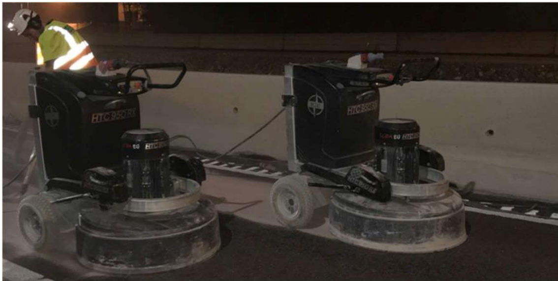
Figur 28. Tandemslipning av hjulspår på E4/E20 med två HTC 950 RX. Foto: Skanska.
