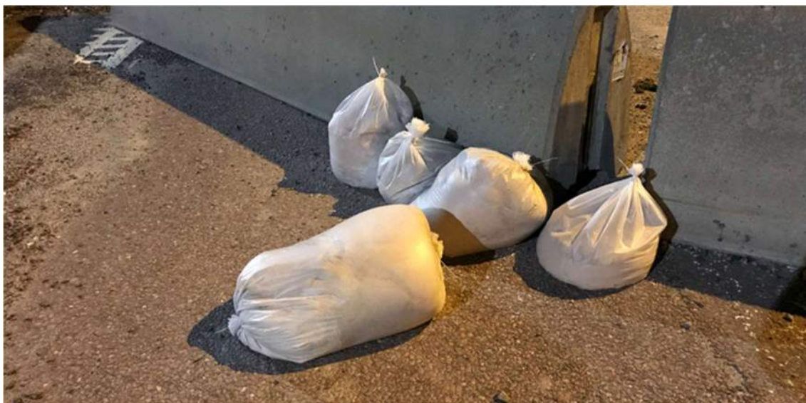
Figur 32. Slipdammet efter en natts arbete uppsamlat i påsar. Foto: Skanska.
