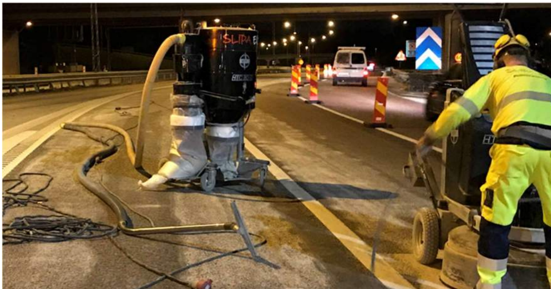
Figur 30. För att samla upp det alstrade slipdamm användes två för ändamålet avsedda dammsugare. Foto: Skanska.
