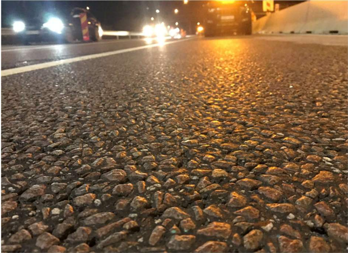
Figur 3. Exempel på typisk beläggningsyta på E4/E20 vid visuell inspektion. Foto: Skanska.
